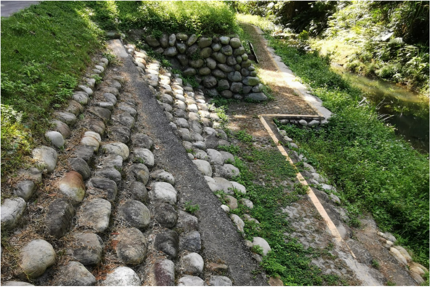
水保局於東勢林場四角林野溪建置三種木格框、栽植槽、砌石護岸等水保設施
