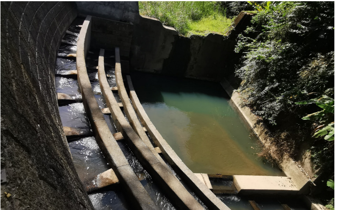
台灣第一座側坡迂迴式的魚梯
