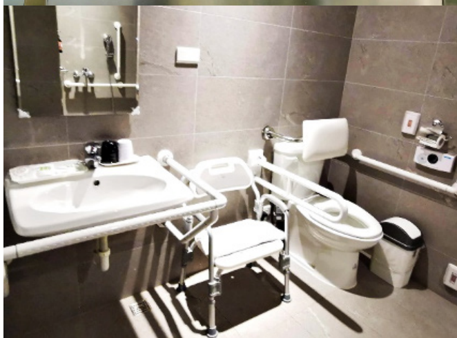
園區有醒目可見的無障礙廁所的告示牌及無障礙設施
